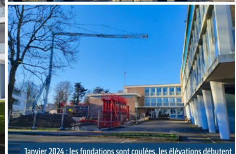
Janvier 2024 : les fondations sont coulées, les élévations débutent
